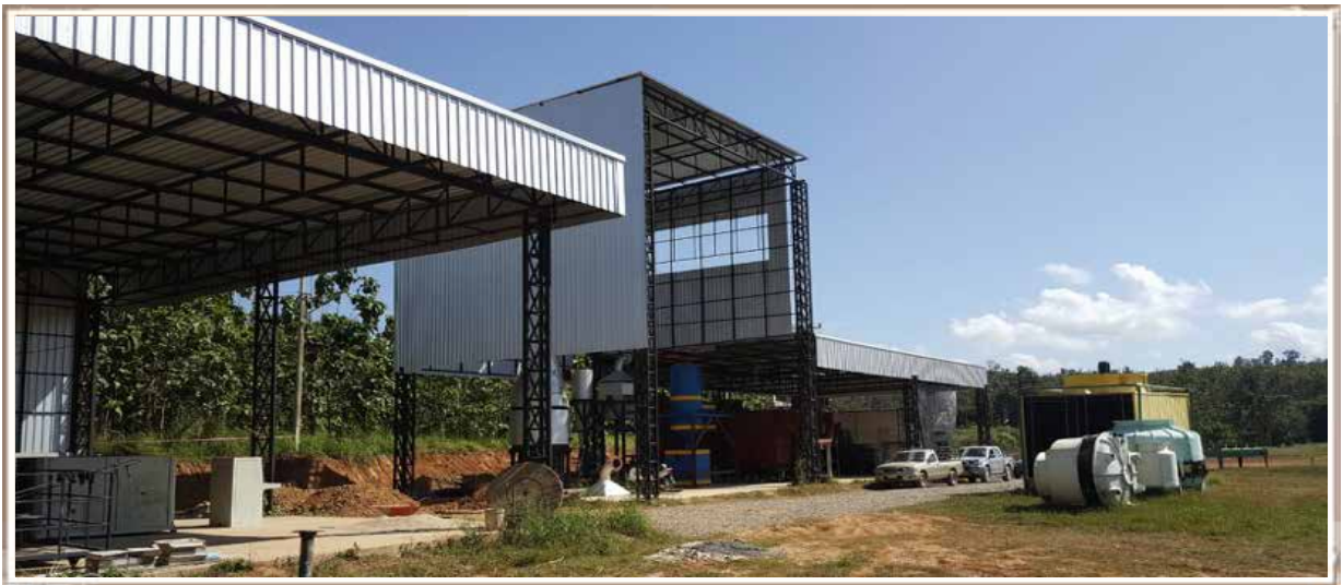
ภาพภายในโครงการโรงไฟฟ้า อำเภอลอง จังหวัดแพร่ ขณะนี้อยู่ระหว่างการก่อสร้าง
